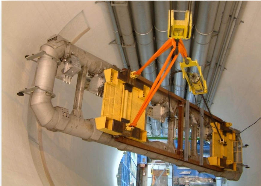
Descente d'une bobine de l'aimant toroïdal (110t) dans la caverne d'ATLAS
