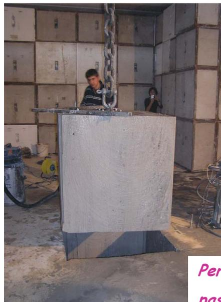
*Perçage de la dalle pour le passage de la ligne verticale*
