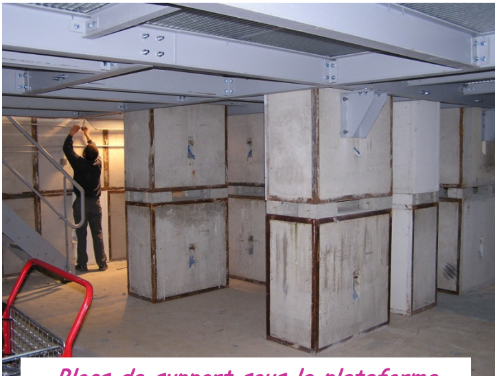
Blocs de support sous la plateforme
