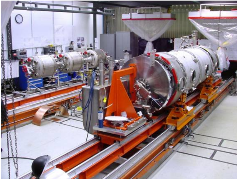
Exemple d'assemblage de cryomodule (SNS)
