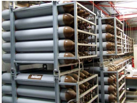
Stokage du gaz à 200 bars équivalent à 3 000 L de liquide
