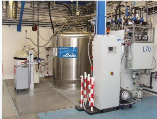
Liquéfacteur pouvant produire 70L/h d'hélium liquide
